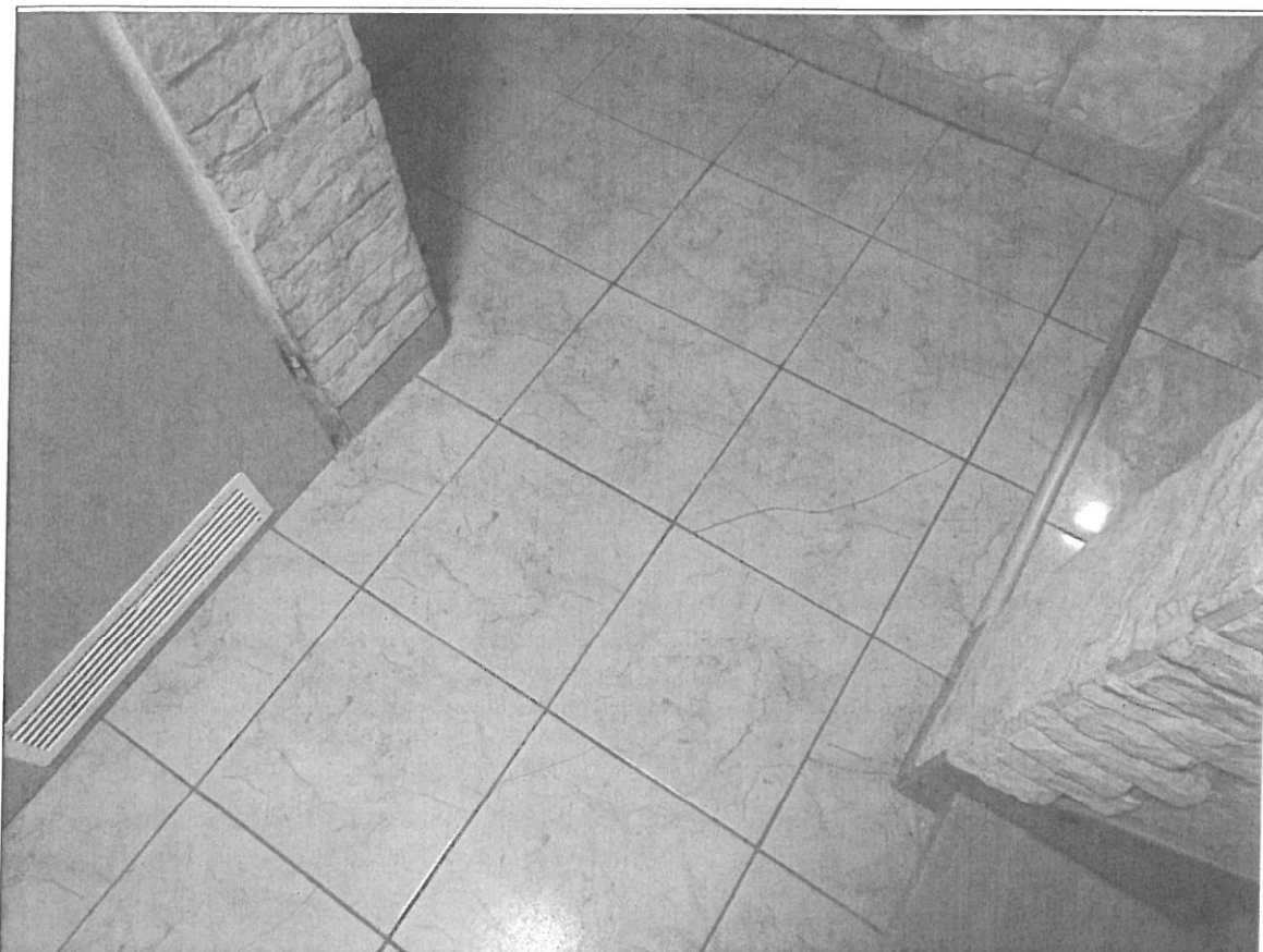
Pęknięte płytki podłogowe (piwnica budynku nr 143)
