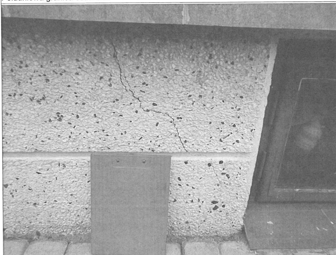
Spękania w fundamencie
