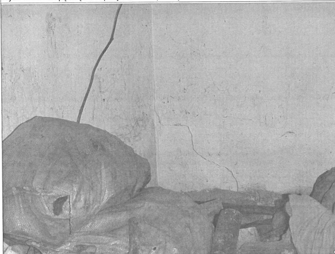
Pęknięcia w ścianie kotłowni (budynek nr 143)
