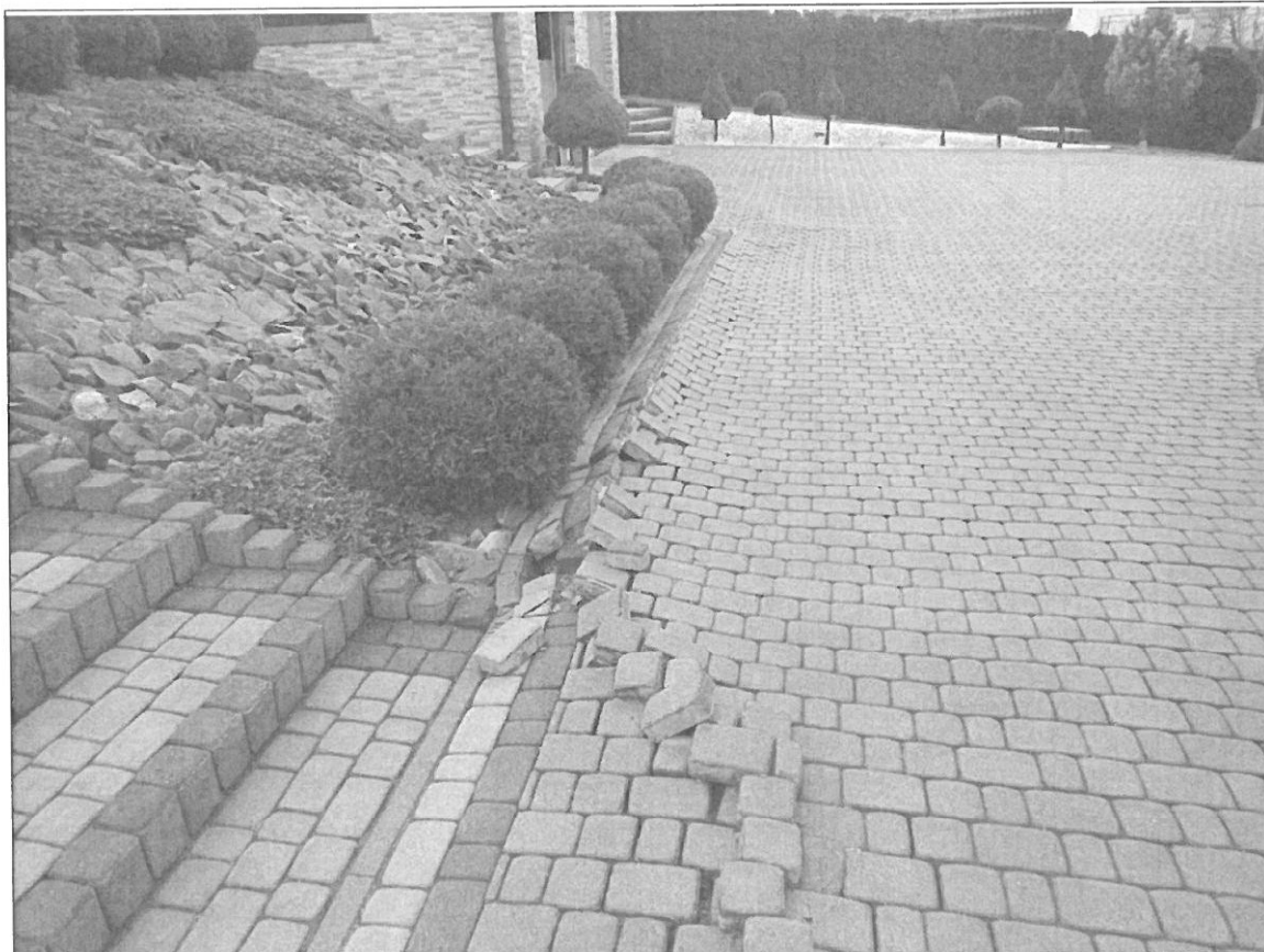
Uszkodzona kostka brukowa powyżej budynku nr 171
