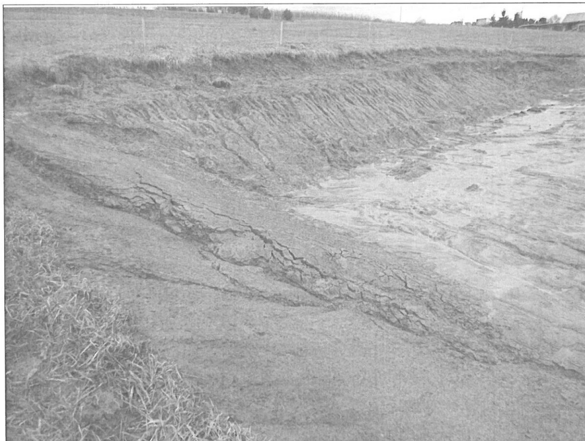
Uszkodzona ściana wkopu, poniżej której planowane jest posadowienie budynku mieszkalnego
