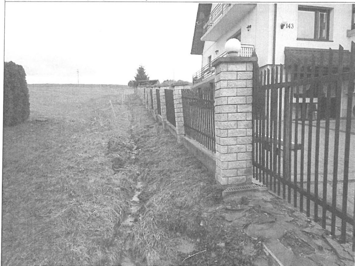
Widoczne odchylenie od pionu ogrodzenia
